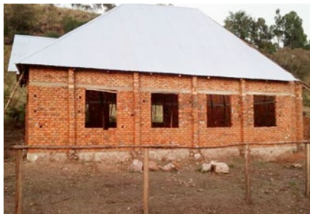
Das Dach für die neue Kirche in Kagera A, Tansania, gefördert durch die VEM. Foto: VEM
